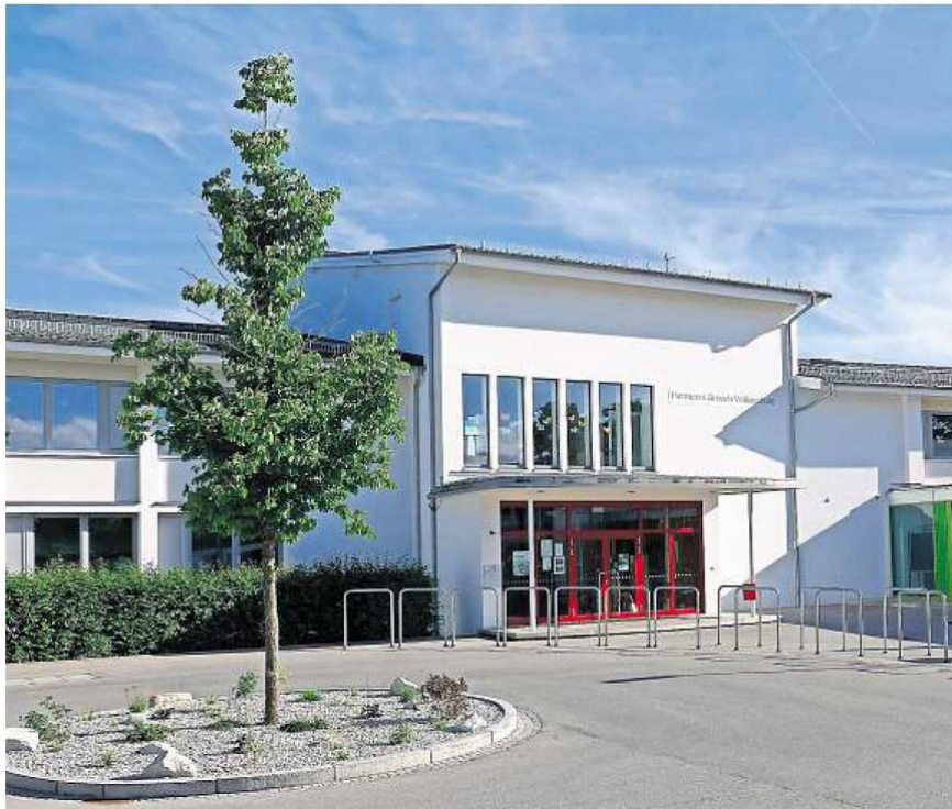
Die Hermann-Grosch-Grundschule in Weitramsdorf: Für den Diplom-Ingenieur und Architekten Konrad Fischer ein Beleg dafür, dass Wärmedämmung nichts bringt. Foto: Wolfgang Braunschmidt
